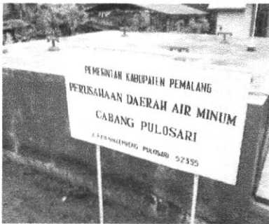
Reservoir I 100 M 3 (Pompa)
