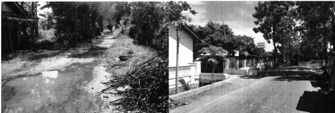
Gambar II.13 (a) Jalan rusak menuju pantai di Desa Tasikrejo; (b) Jalan beraspal penghubung antar desa.
